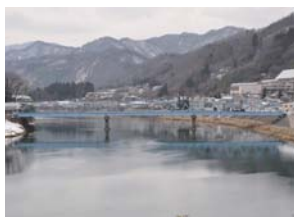
平成23年度 県単道路橋梁維持(橋梁修繕)事業に伴う設計業務委託 長野市新町橋
